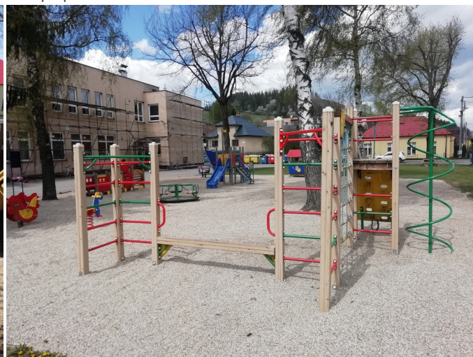
stav po prestavbe
