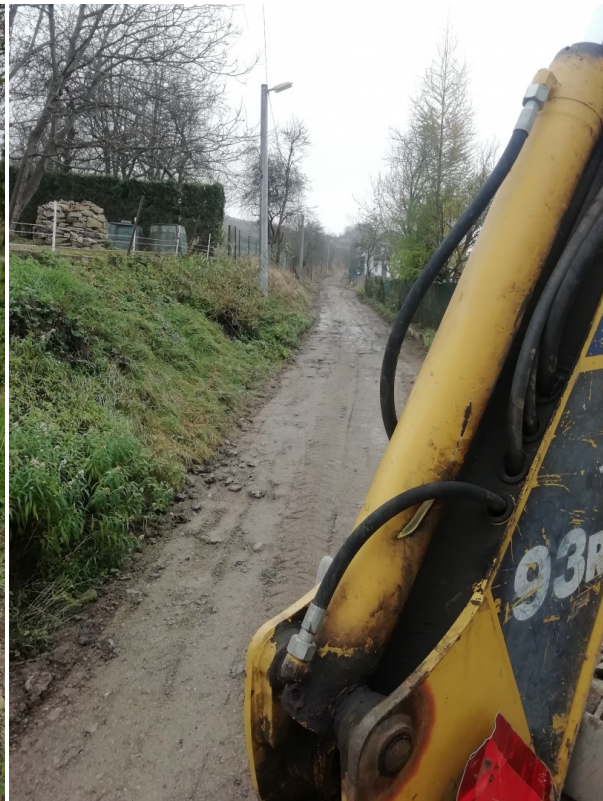
stav po rekonštrukcii
