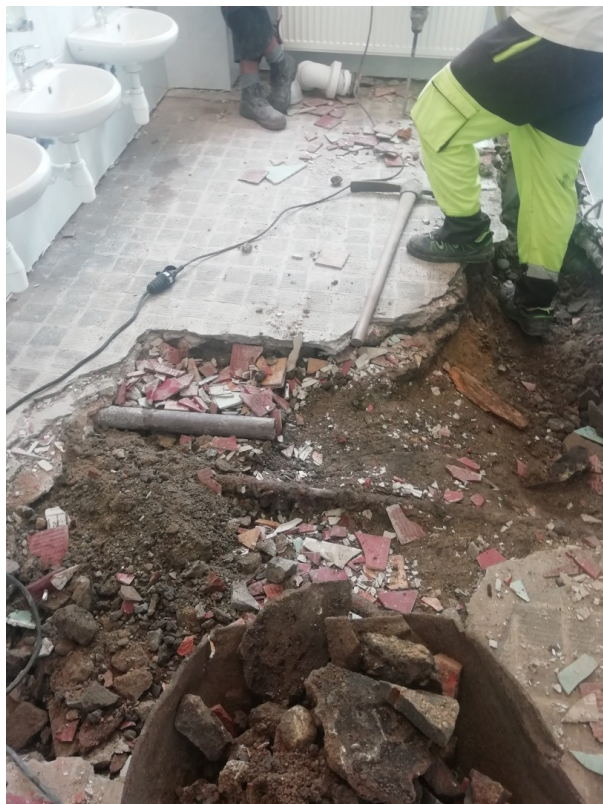
stav pred rekonštrukciou
