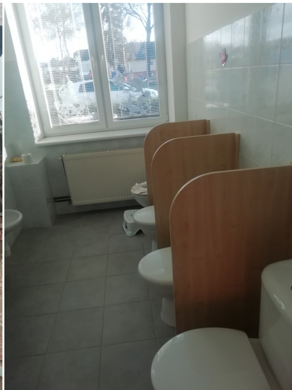
stav po rekonštrukcii
