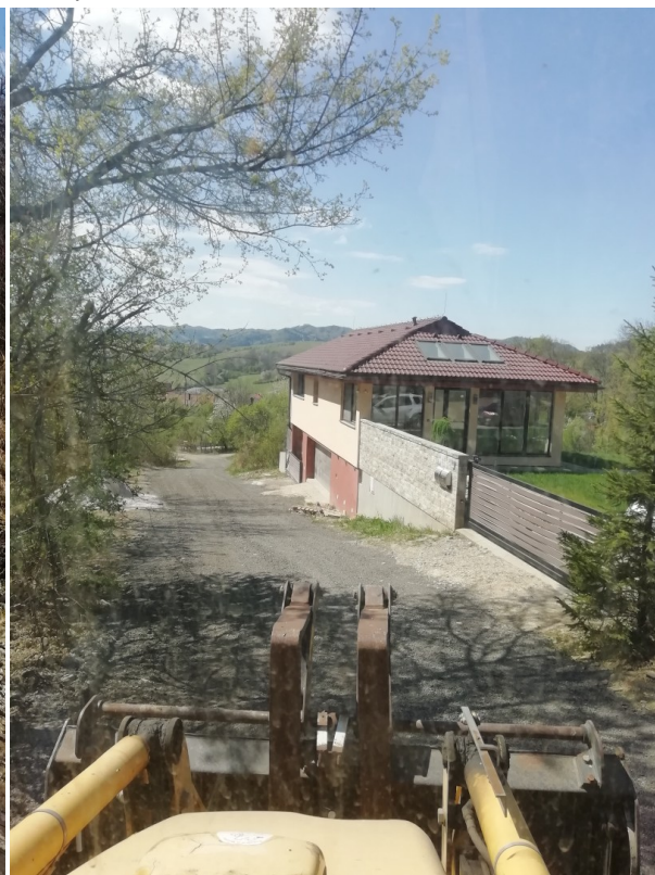
stav po rekonštrukcii
