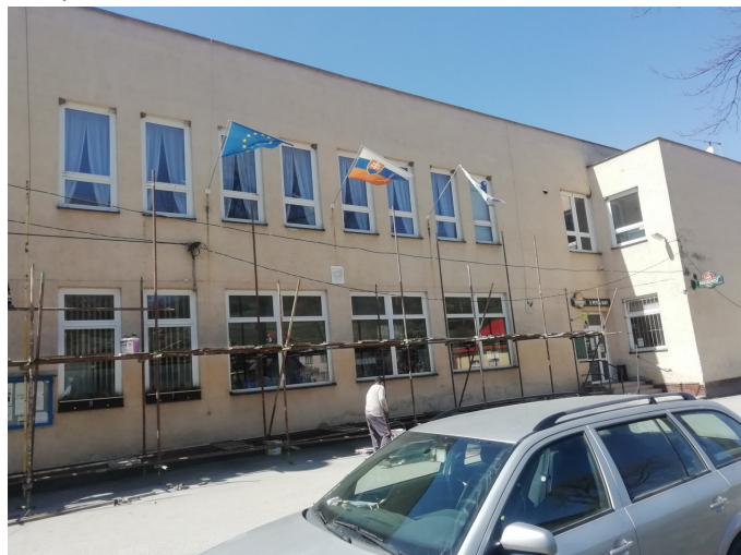
stav pred rekonštrukciou
