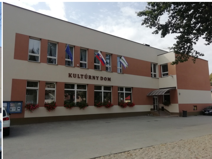
stav po rekonštrukcii
