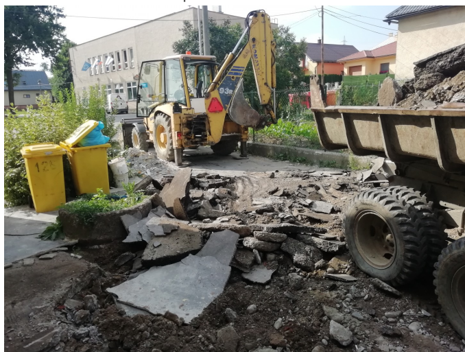
stav pred rekonštrukciou
