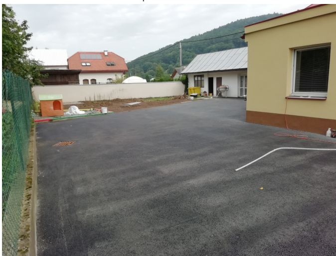
stav po rekonštrukcii
