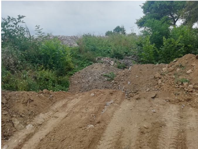
stav pred sprejazdením
