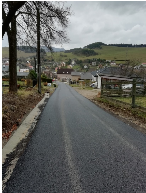
stav po oprave
